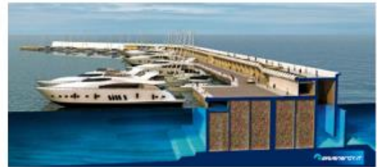
Nuova porta turistica di Roma: R. Arena, REWEC3, nuova diga portuale per la produzione di energia elettrica dalle onde di mare. Green City Energy/Med. 12/13 Nov. 2015.
