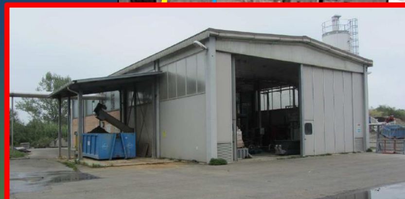
TRATTAMENTO CHIMICO FISICO E FILTROPRESSA PER DISIDRATAZIONE FANGHI CHIMICI
